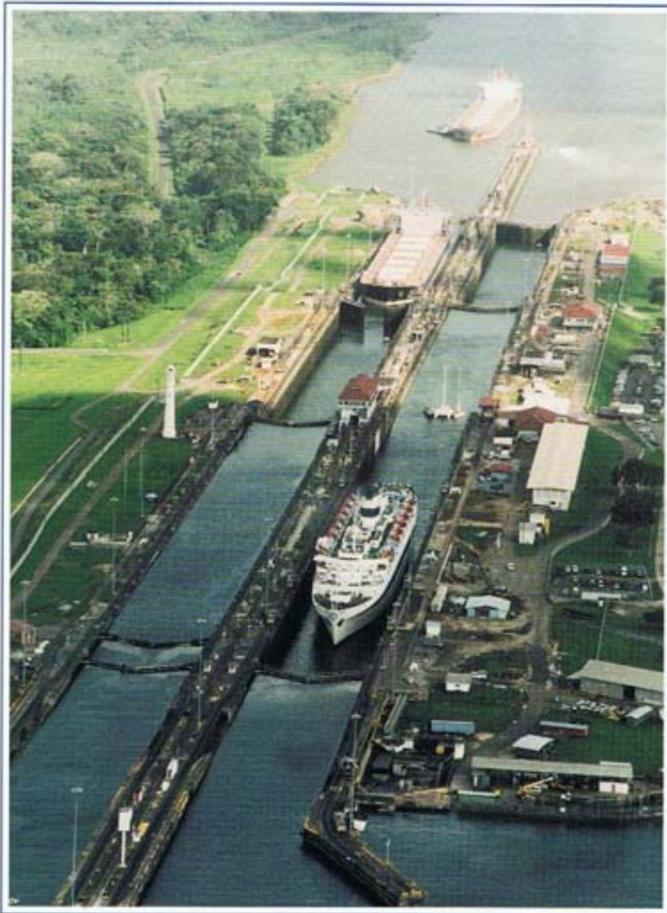
EL CANAL DE PANAMA - THE PANAMA CANAL
